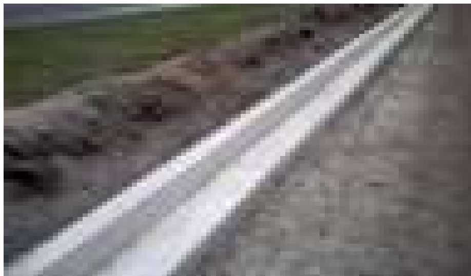
Figura 18: Sarjeta associada ao meio fio ou ao guia. Fonte: FUNASA (2016).
